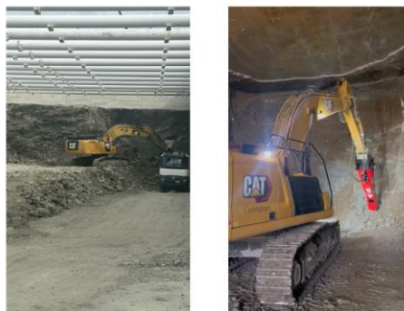
Intervento sulla S.S. n. 64 "Porrettana" – località Casalecchio di Reno (BO)
