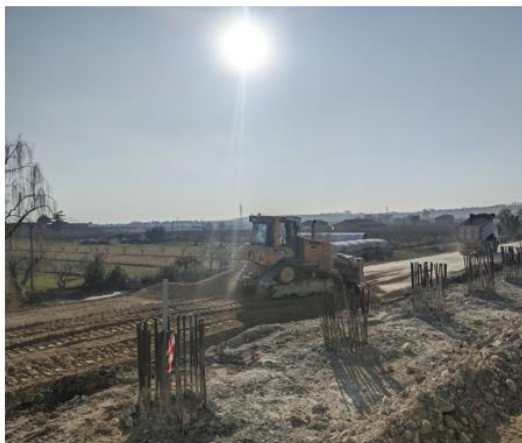
Scavi e formazione dei rilevati ferroviari MI-VE - Cantiere CEPAV (Consorzio Eni Per l'Alta Velocità) DUE
