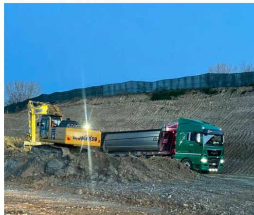
Scavi e formazione dei rilevati ferroviari MI-VE - Cantiere CEPAV (Consorzio Eni Per l'Alta Velocità) DUE
